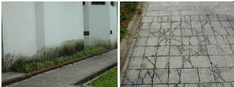
Estado actual de la construcción (vease archivo del registro fotografico PEMP 2012)
