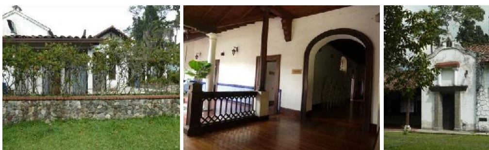
Registro fotografico del inmueble 2011
