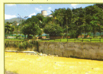
Antigua casa de las máquinas, quebrada Doña María - 2011
