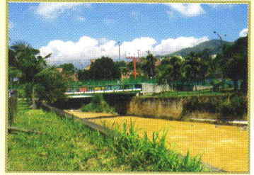
Puente sobre la quebrada Doña María - 2011
