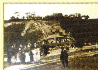
Casa de las máquinas, quebrada Doña María - 1920
