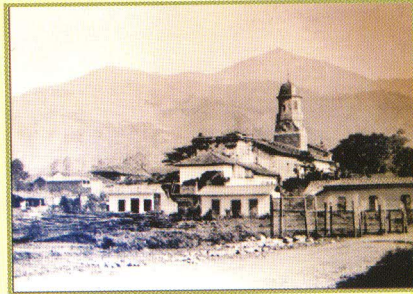
Construcción de la nave central de la iglesia - 1933
