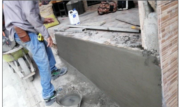
Fotografía 23. Revoque de recintes
