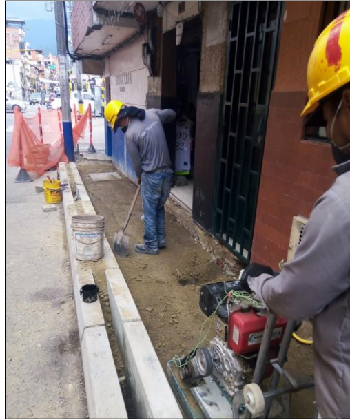
Fotografía 7. Instalación de base con chencha
