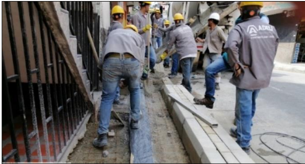
Fotografía 15. Vaciado de andén.
