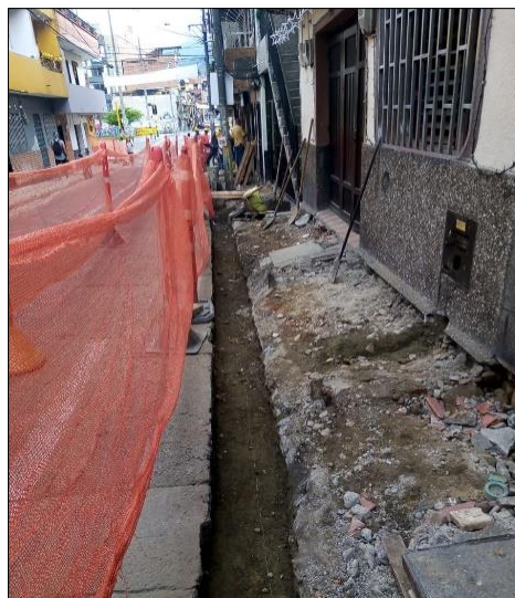
Fotografía 3. Excavación de brecha
