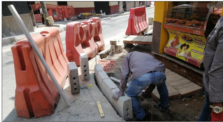
Fotografía 4. Colocación de cordones
