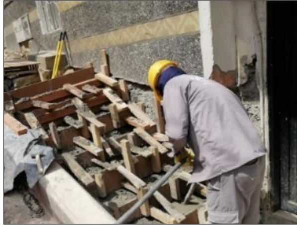
Fotografía 24. Vaciado y vibrado
