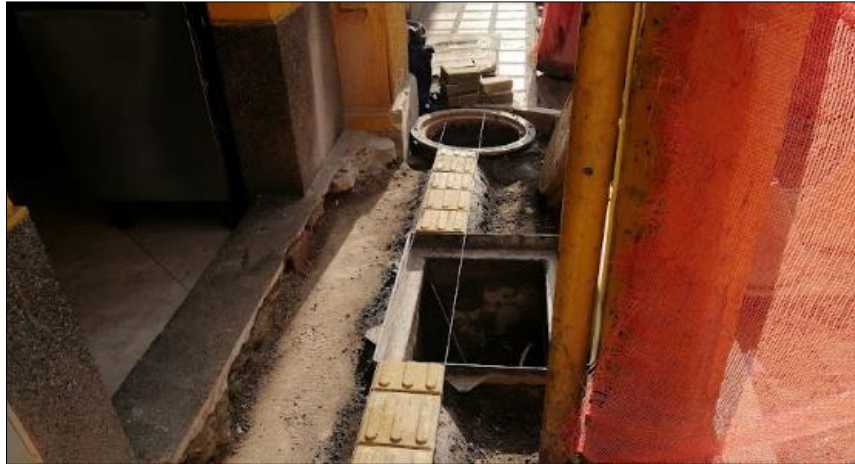
Fotografía 12. Instalación y nivelación de cajas eléctricas
