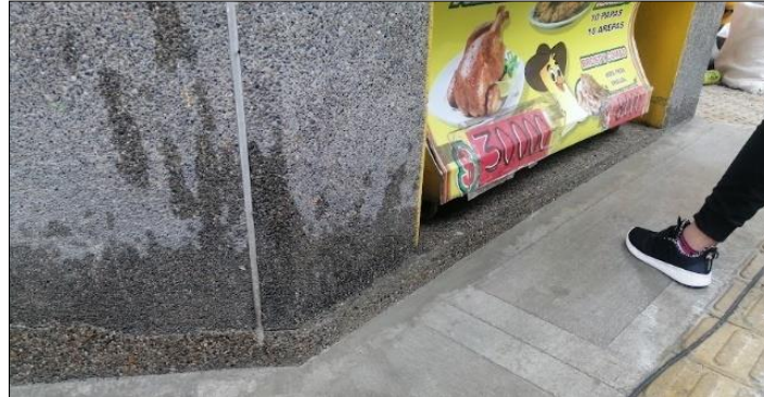
Fotografía 18. Limpieza de granito
