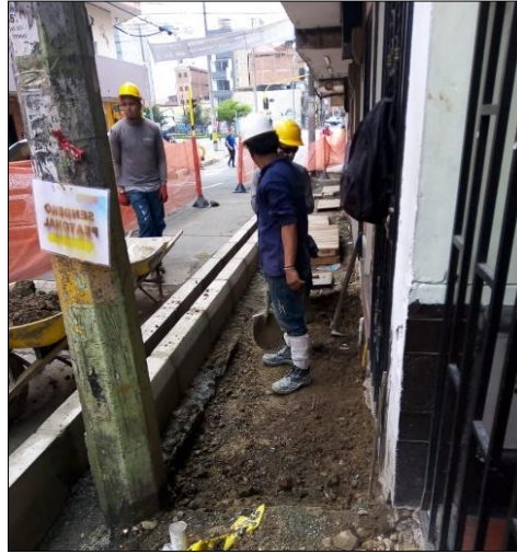
Fotografía 5. Excavación, nivelación de terreno
