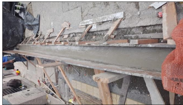
Fotografía 19. Vaciado de muro cordón
