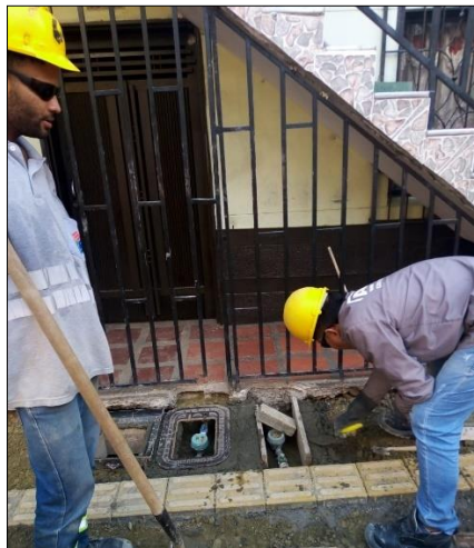
Fotografía 11. Formaleta para contadores
