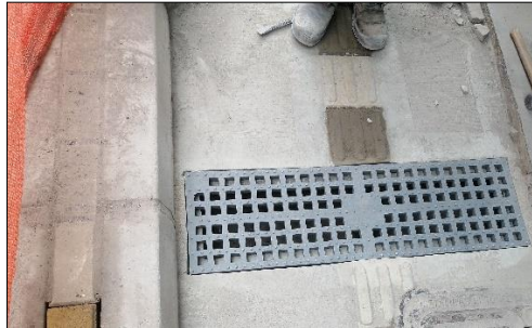
Fotografía 6. colocación de tapa de cárcamo
