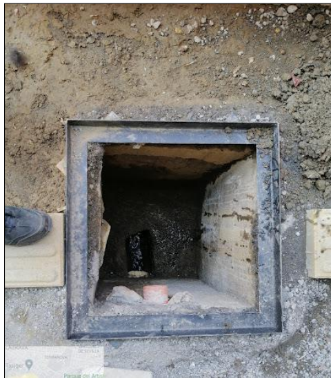
Fotografía 13. Instalación y nivelación de cajas residuales
