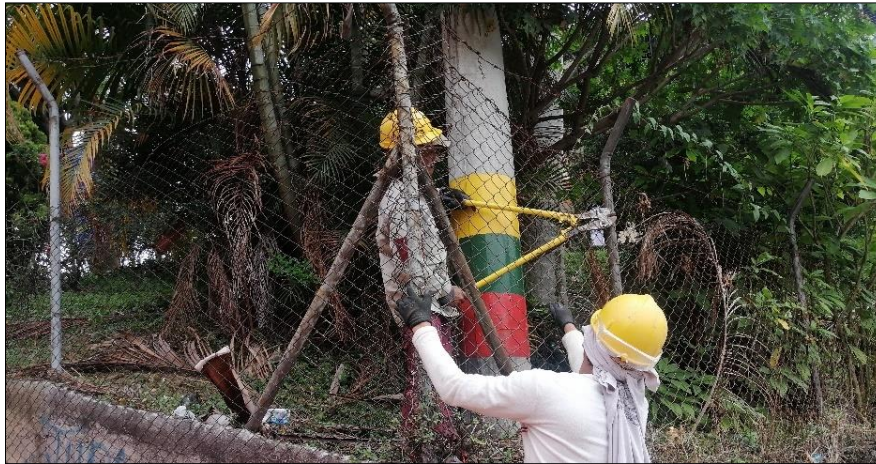
Fotografía 25. Levantamiento de malla eslabonada
