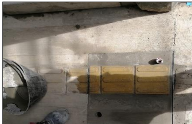
Fotografía 17. Colocación de tapas
