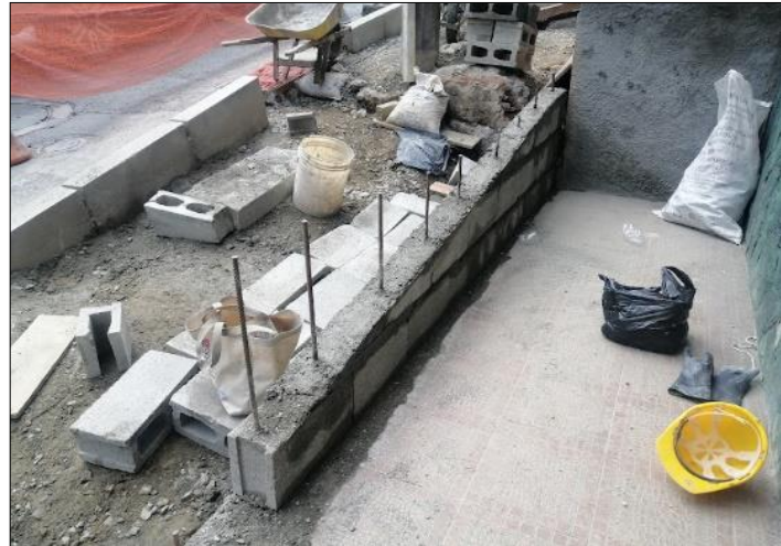
Fotografía 21. Vaciado de muro de contención
