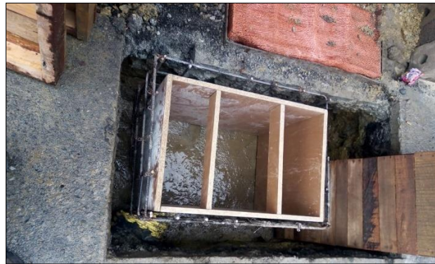
Fotografía 14. Colocación de canasta y formaleta
