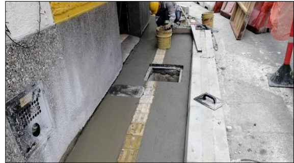
Fotografía 16. Vaciado de andén
