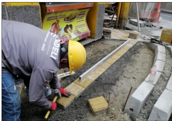
Fotografía 8. Instalación de loseta guía.
