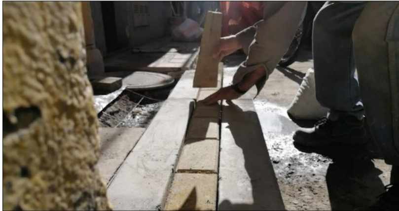
Fotografía 10. Instalación de loseta visual
