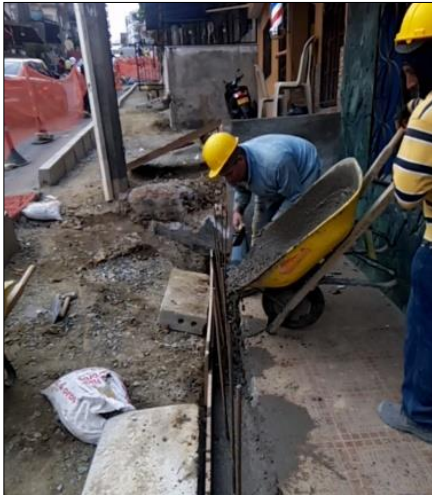
Fotografía 20. Vaciado de viga
