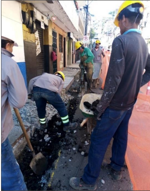
Fotografía 1. Demolición de andén
