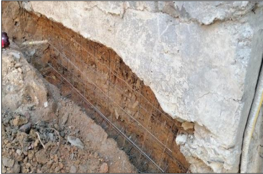
Fotografía 22. Malla electrosoldada en recinte
