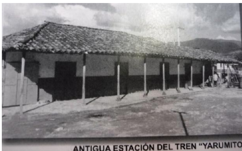
La Estación en 2001 9 . Se aprecia una mejor condición del techo
