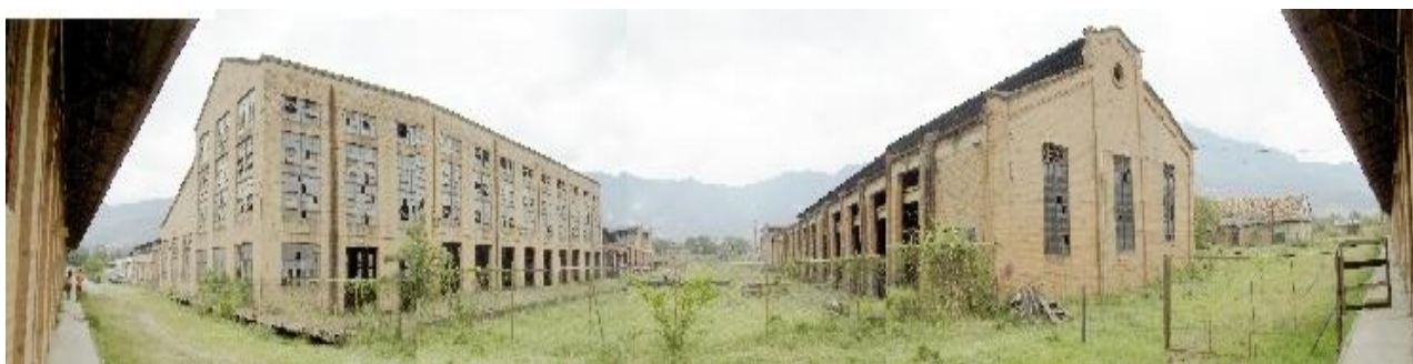
Antes de la intervención (2006)
