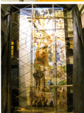
Andamios y pintura
