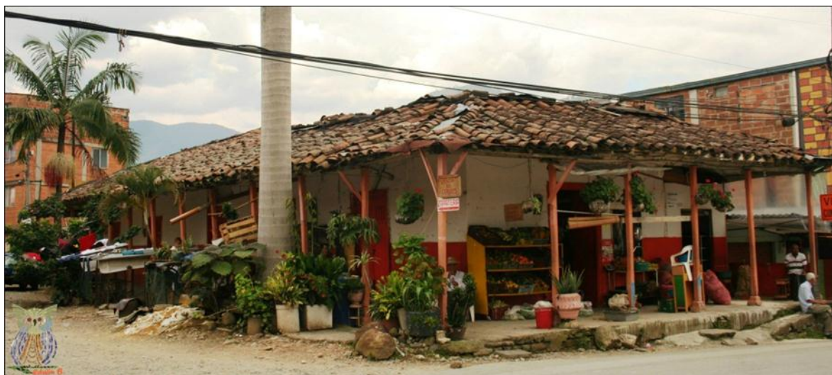
Figura 7. Antigua Estación Yarumito del ferrocarril año 2013. Recuperado de Bienes de Interés Cultural –BIC. Itagüí. Estación Yarumito, Corporación CIPAS., 2013. Recuperado de https://patrimoniositagui.jimdo.com/31-estaci%C3%B3n-yarumito/
