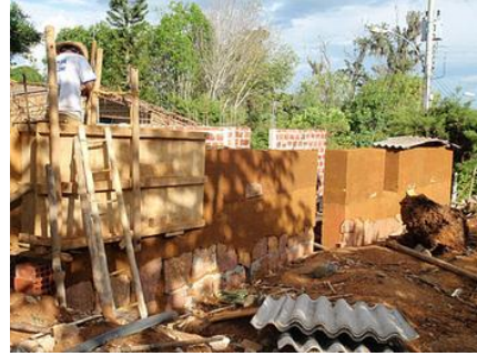
Figura 14. Proceso de construcción de los muros de tapia. Recuperado de Tapia pisada, técnica que se resiste a desaparecer, Agencia de Noticias UN., 2015. Recuperado de http://agenciadenoticias.unal.edu.co/detalle/article/tapia-pisada-tecnica-que-se-resiste-a-desaparecer.html
