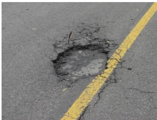
Figura 10. Descascaramiento
