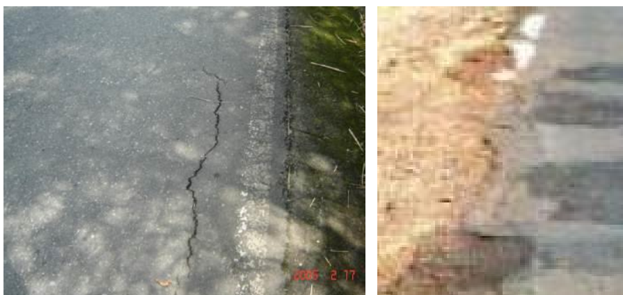
Figura 17. Desintegración de bordes
