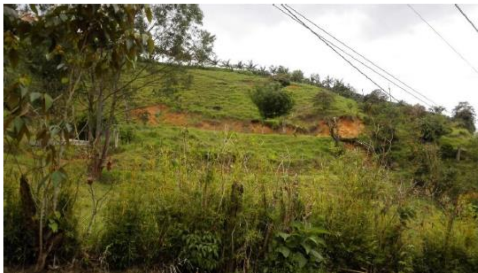
Figura 4. Movimientos en masa asociados a los cortes hechos para la construcción de la vía en la vereda Ajizal. (Universidad Nacional de Colombia, 2018).
