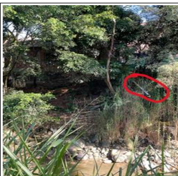
Ilustración 11. Desagües de locales comerciales directamente al cauce de la quebrada
