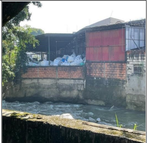
Ilustración 25. Empresa de reciclaje asentada en la ribera de la quebrada Doña María
