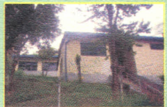
Escuela de la vereda que está cerrada
