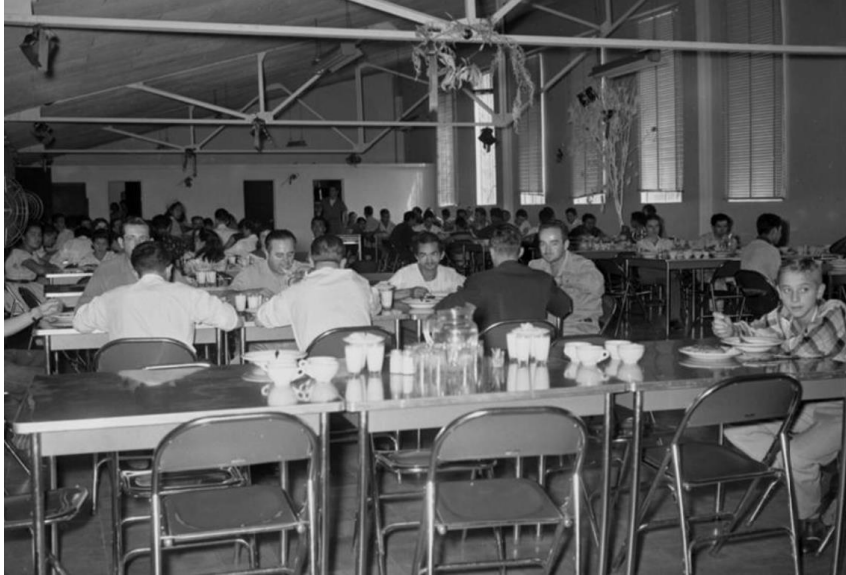
Figura 3.8: Comedor de la Planta de Acabado de Coltejer
