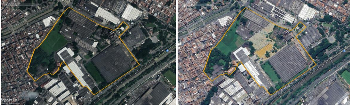
Figura 4.16: Avance de la demolición de Coltejer desde el año 2015 al 2023
