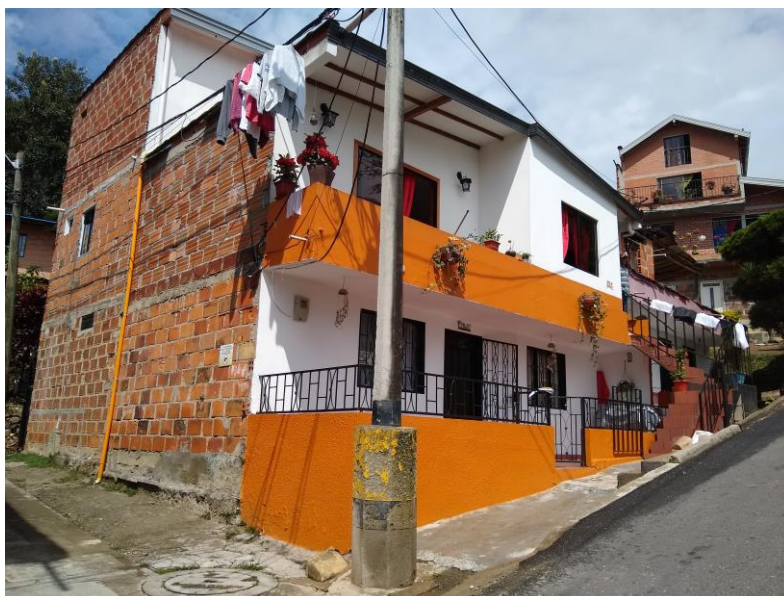
Fig. 5. Fachadas en buen estado
