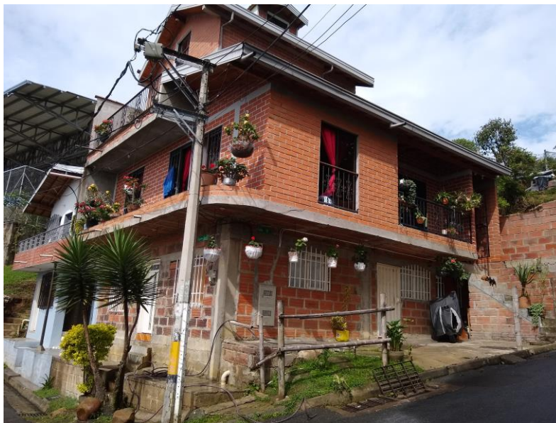
Fig. 4. Fachadas en buen estado
