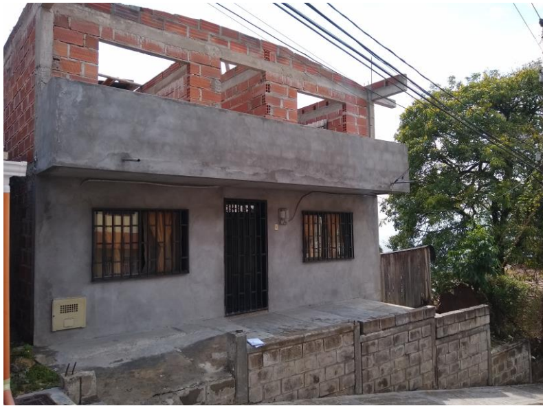
Fig. 6. Fachadas en buen estado
