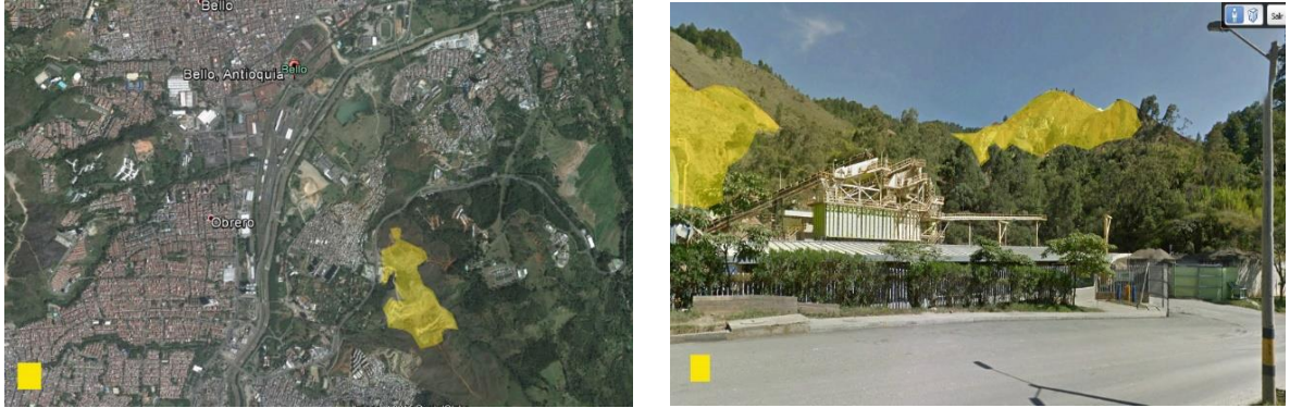
Figuras 28-29. Autopista barrió santa Rita, Municipio de bello.
