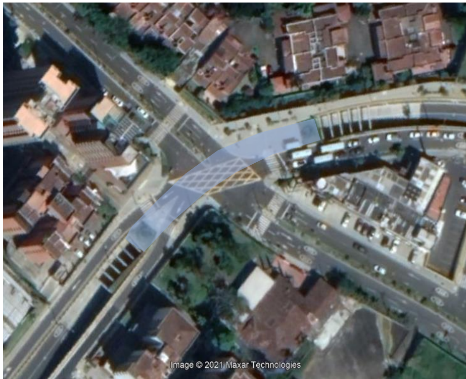
Figura 58. Deprimido Transversal Inferior con Loma Los Parra, tomado de Google Maps, (2021)
