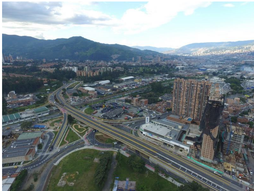
Figura 6. Intercambio vial Rafael Uribe Uribe. Tomado de Constructora Conconcreto, (2020)
