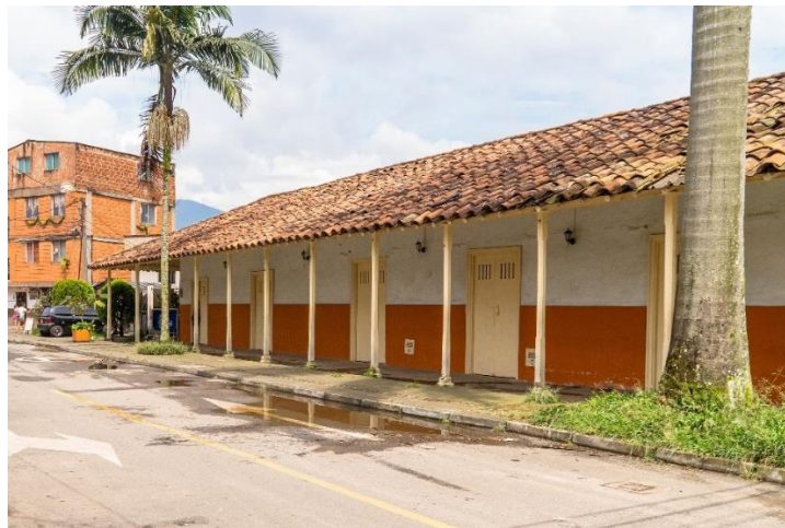
Figura 17. Antigua estación Yarumito
