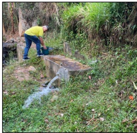
Fig 9. Inspección de las condiciones del desarenador. Fuente: Elaboración propia.
