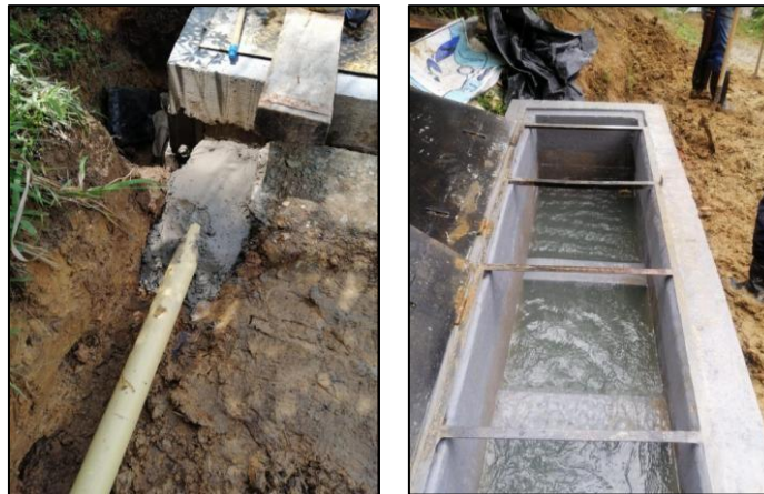
Fig 12. Construcción tanque desarenador
