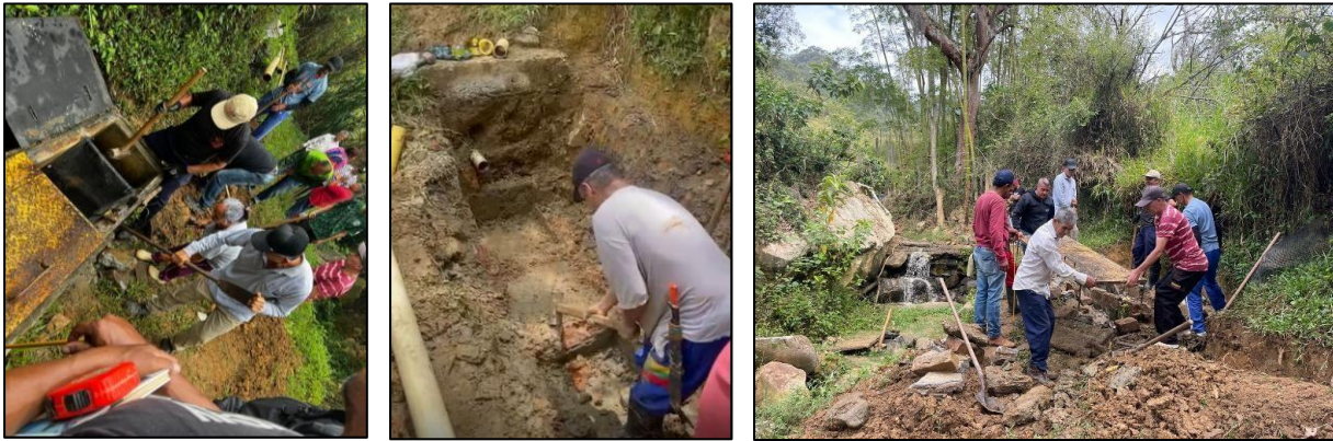
Fig 11. Proceso demolición del tanque existente. Fuente: Elaboración propia.
