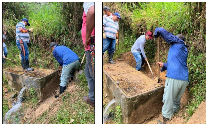
Fig 10. Primera fase de demolición. Fuente: Elaboración propia.
