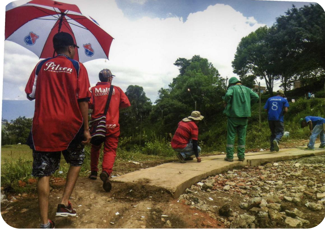
Inicio de la construcción por gestión comunitaria del camino que une a San Francisco y a El Limonar (foto: 2015, Jessica Martínez)
