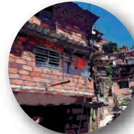
Desplazamiento longitudinal / Escalonamiento
