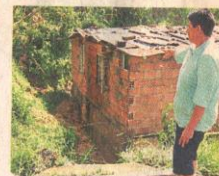
GLORIA ELENA ROBLEDO RAMÍREZ en peligro por derrumbe en Los Zuleta
