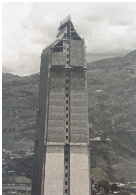
Construcción Edificio Coltejer 1971
