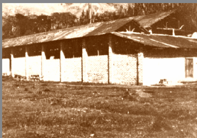
Instalaciones de Curtimbres Independencia. Archivo municipio de Itagüí
