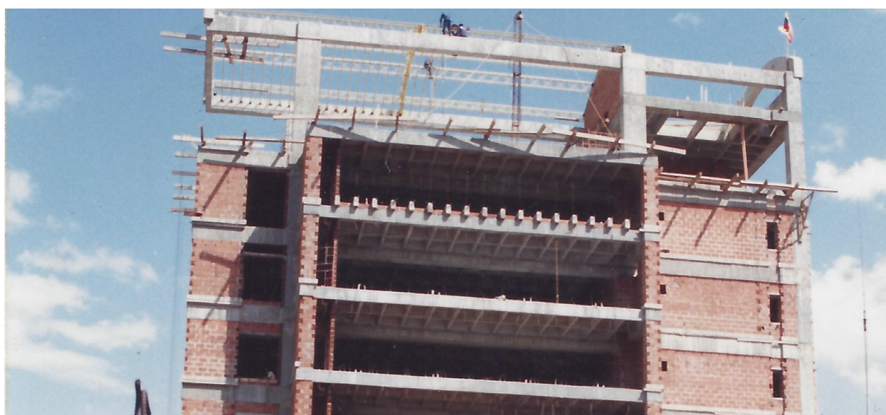
Construcción del CAMI. / Archivo privado del Sr. Mario Montoya.
