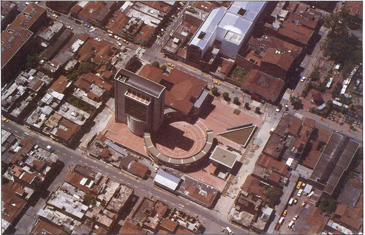
Toma aérea del Centro Administrativo Municipal de Itagüí, CAMI, primera etapa
