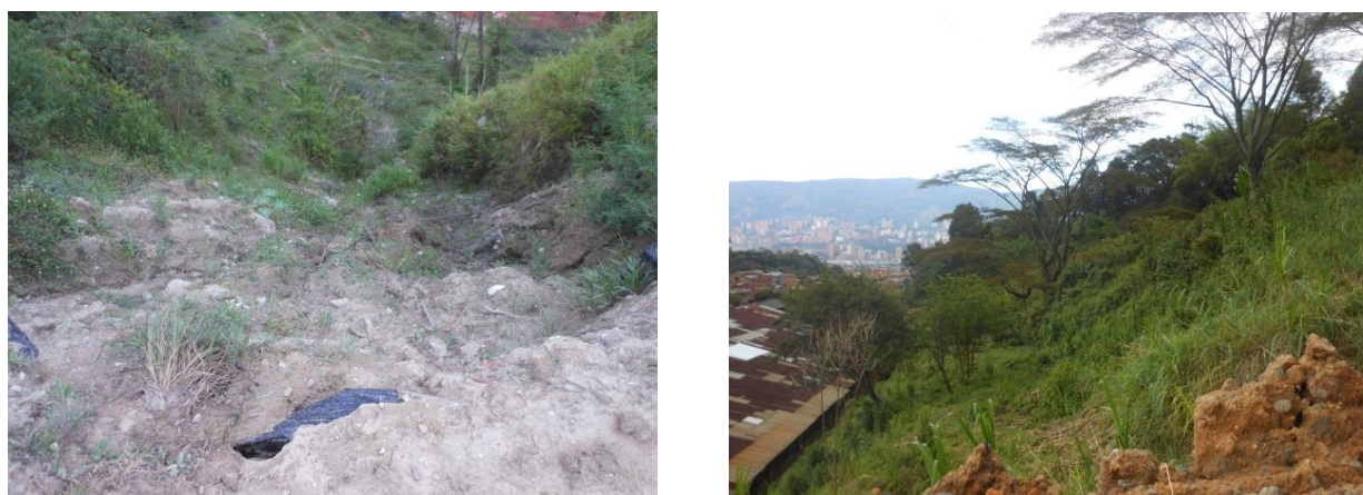
Figura 22. Fotografías Zonas de alto riesgo de movimientos en masa. Taludes inestables en áreas de explotación minera del lote. Fuente: Fotografías tomadas en visitas de campo realizadas al Área de Planificación.
