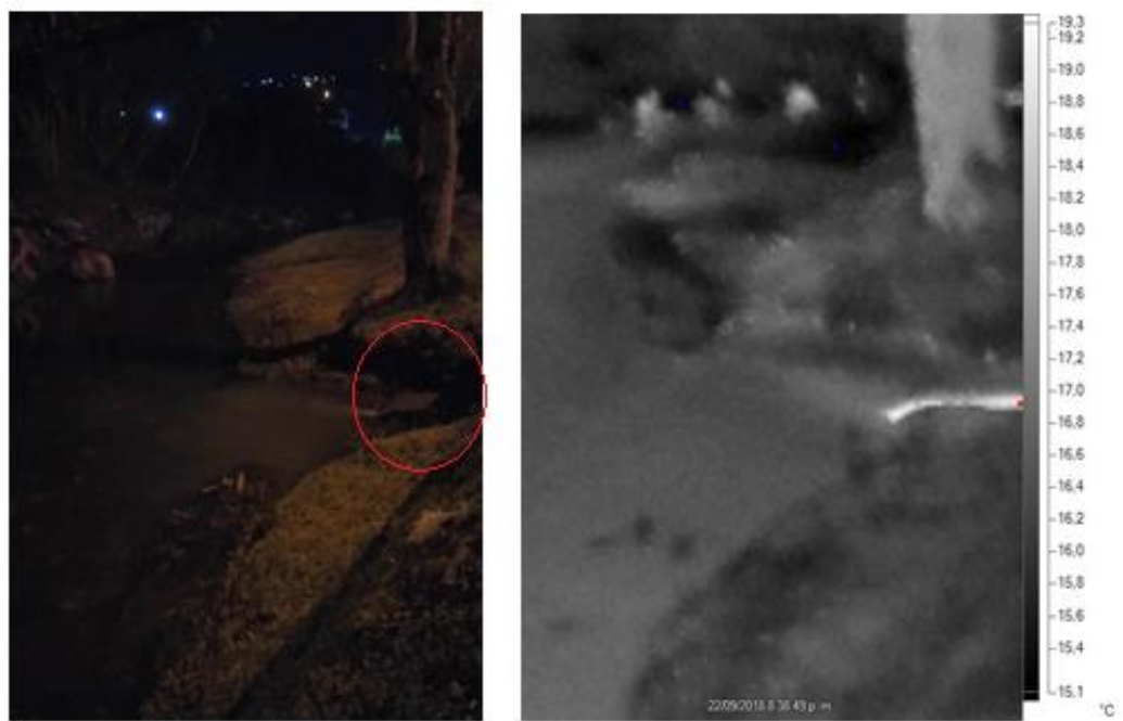
Foto 9: Vertimiento de agua residual en la quebrada La Mosca (imagen RGB izquierda, térmica derecha)
